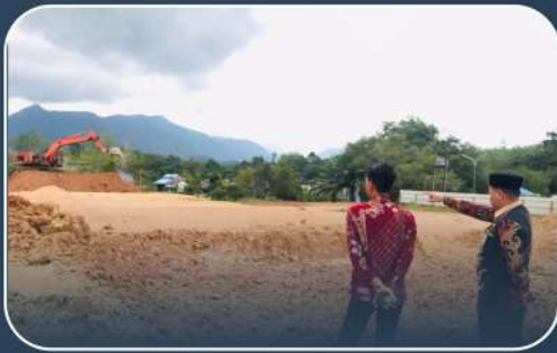
Ketua dan Wakil pantau progres awal pembangunan gedung kantor PA Bengkayang
