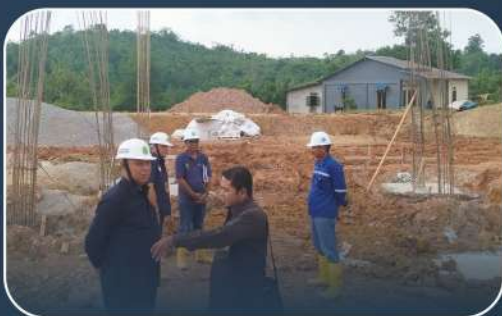
Peninjauan Progres Pembangunan Gedung PA Bengkayang Oleh Tim Internal PA Bengkayang
