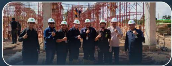
Sekretaris dan Panmud Hukum PTA Pontianak monitoring dan evaluasi progress pembangunan gedung kantor PA.Bengkayang
